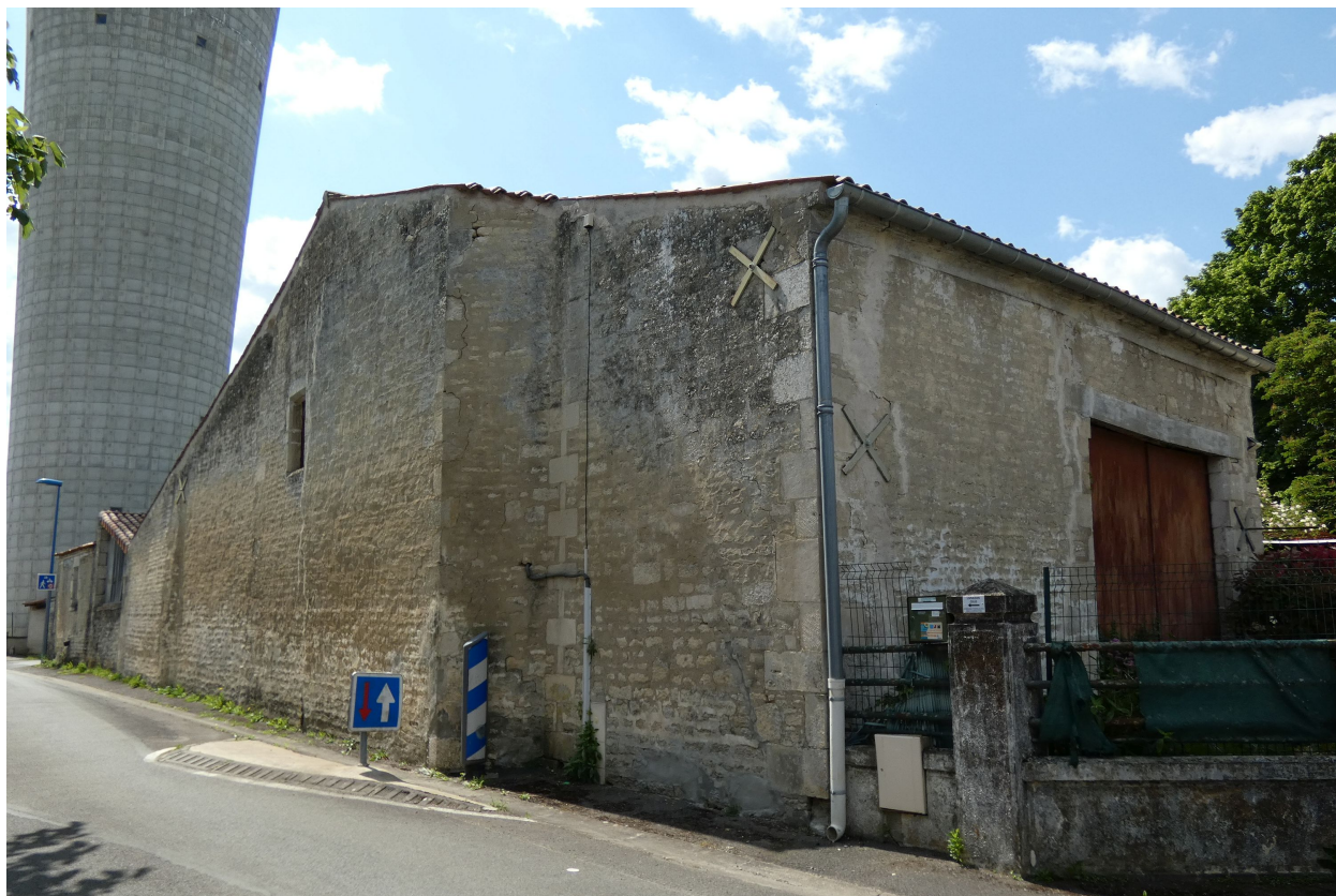
La grange-étable le long de la rue, vue depuis le nord-est.
