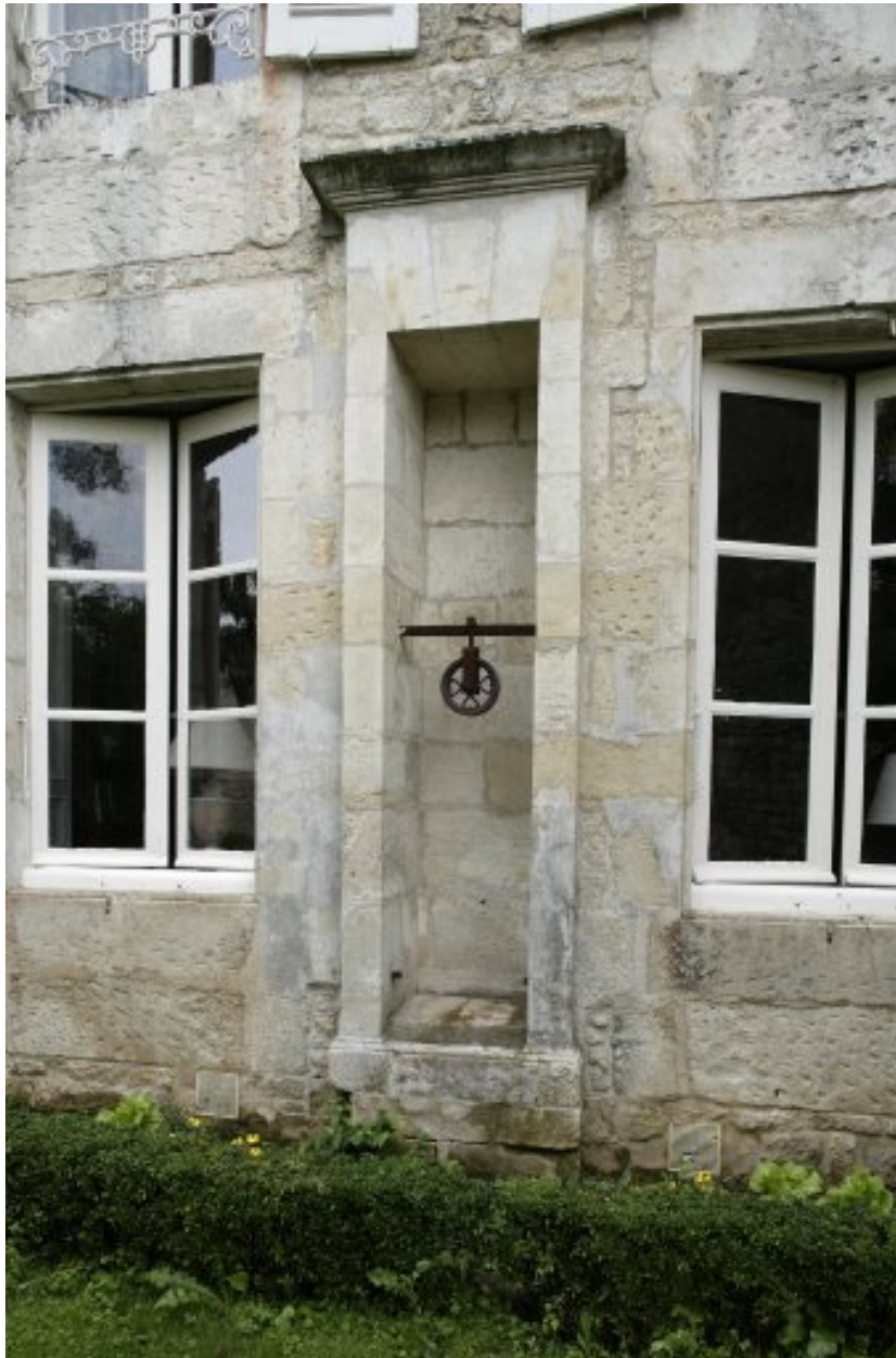
Puits sur la façade donnant sur le jardin.
