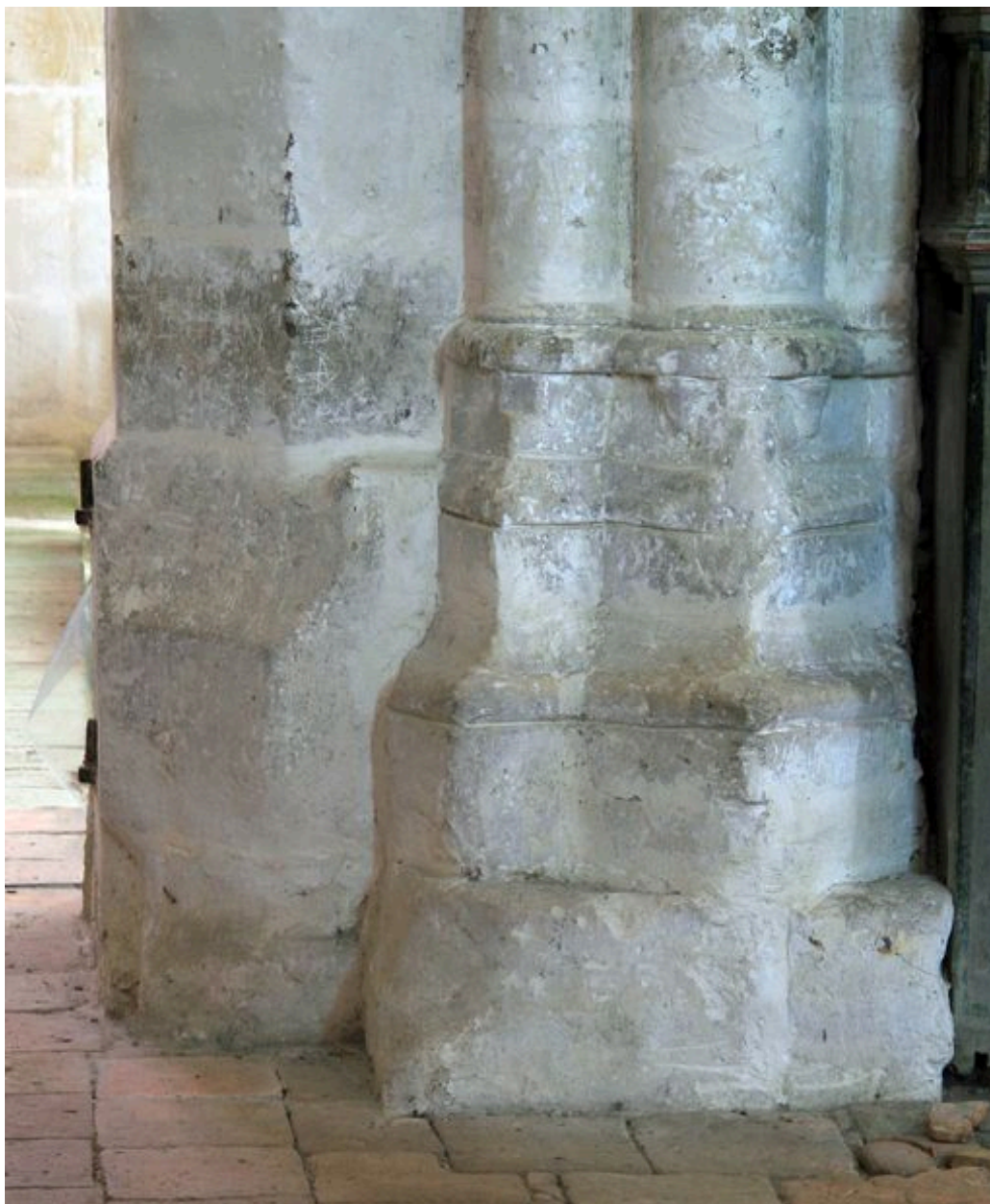
Pilier du chœur : base prismatique.
