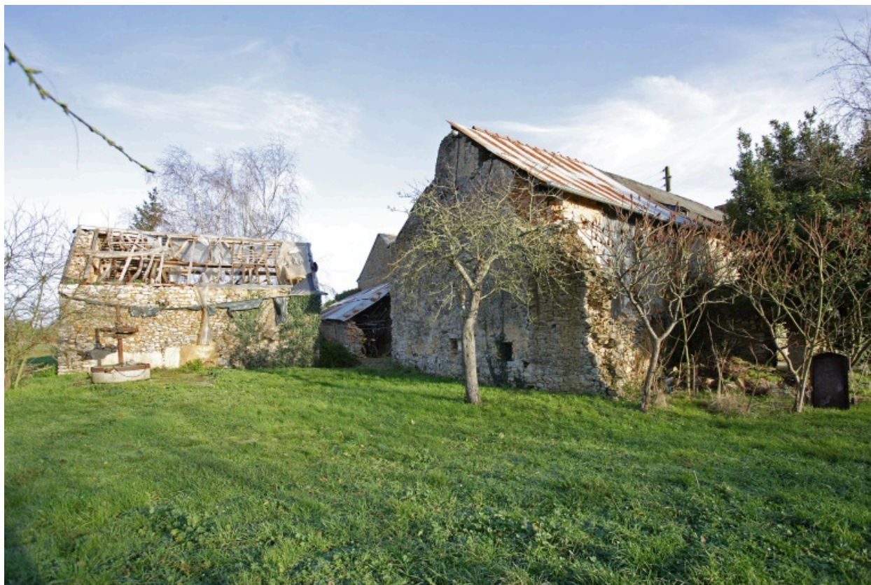
La porcherie et le logis vus depuis l'ouest.
