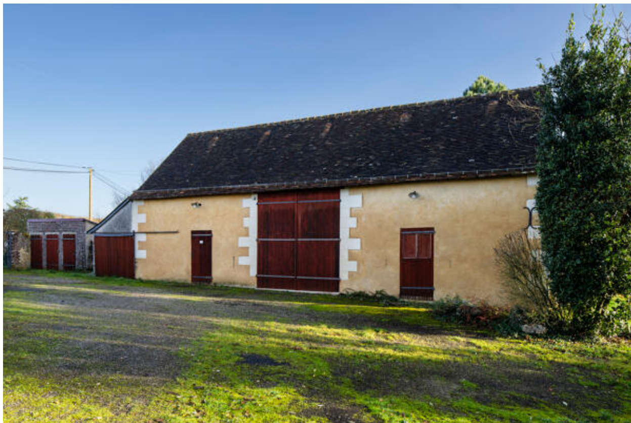
Grange-étable et lieux d'aisance extérieurs.
