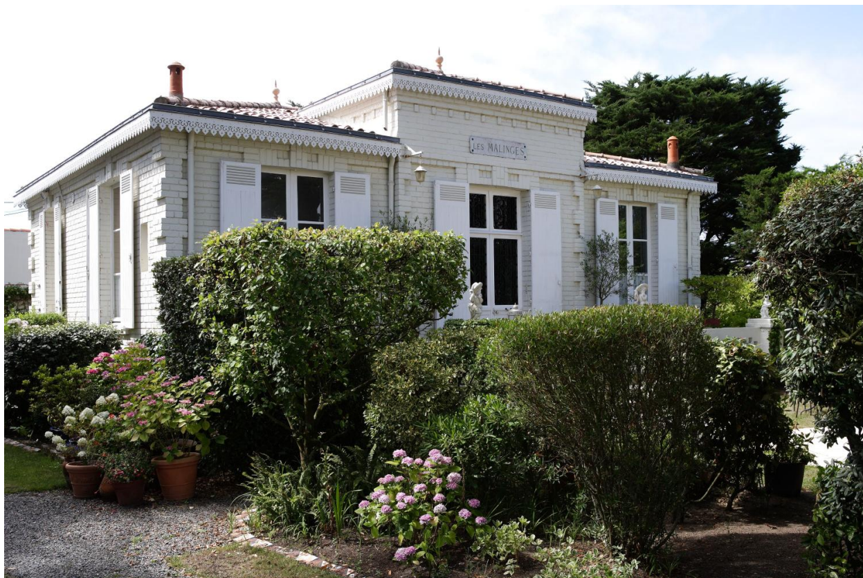
Elévation antérieure vue de l'est.
