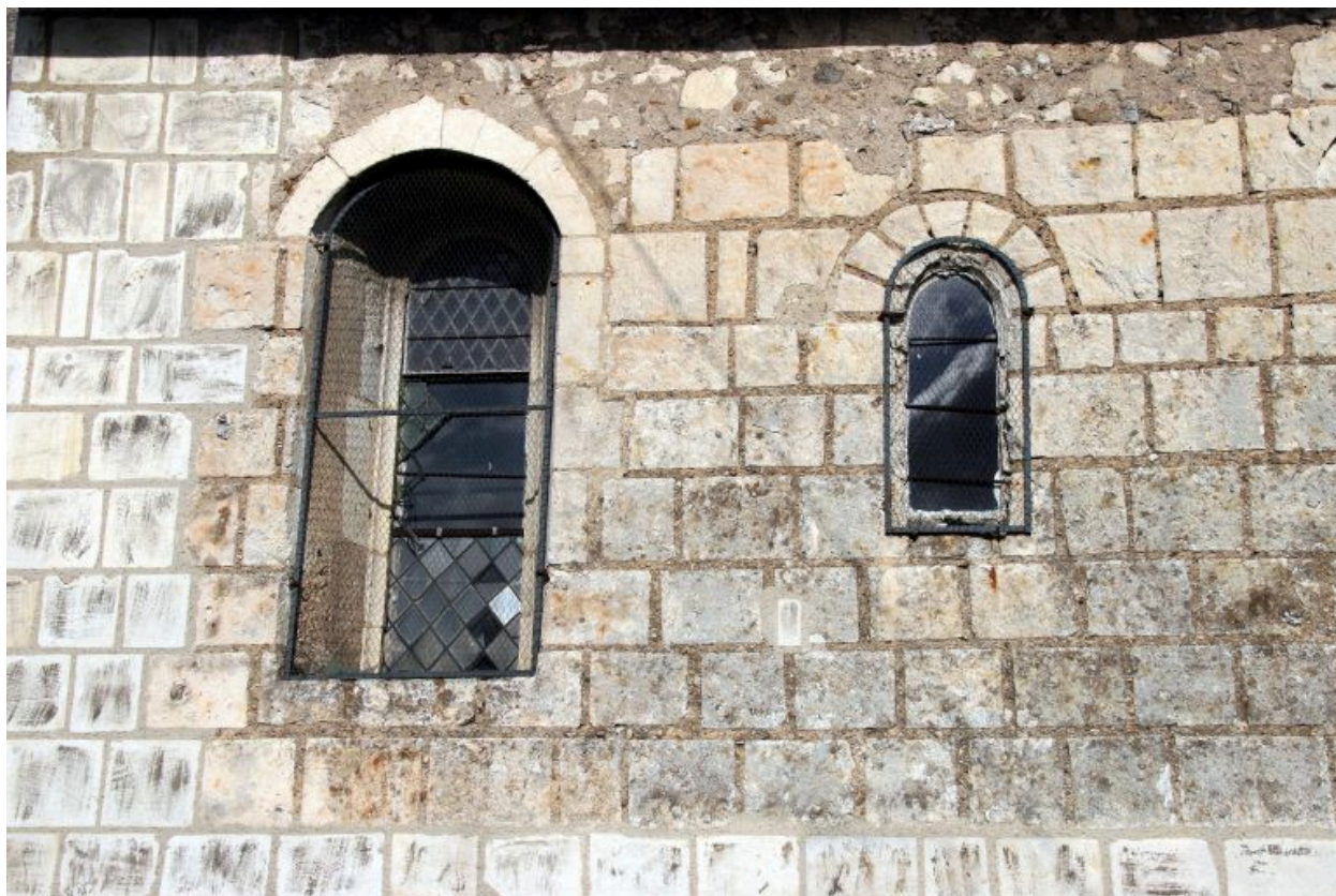
Mur sud du chœur, baies.
