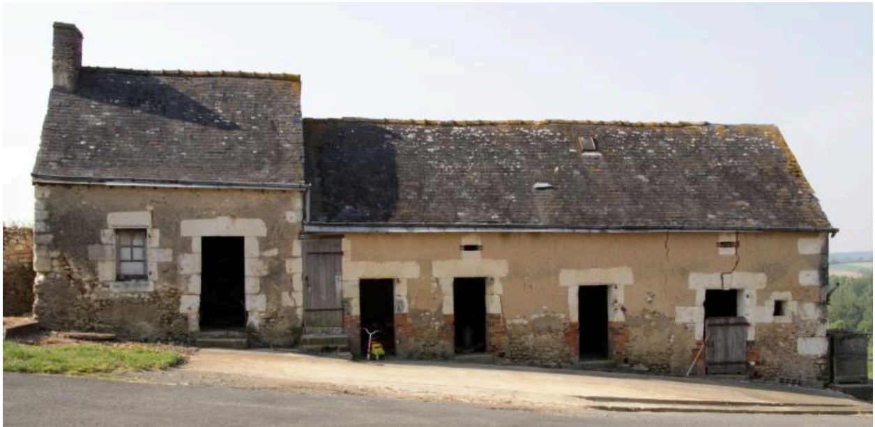
Buanderie et toit à porcs : façade antérieure sur cour.
