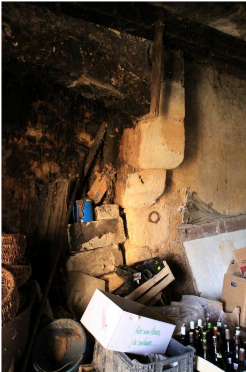
Maison, cheminée : détail corbeau droit.
