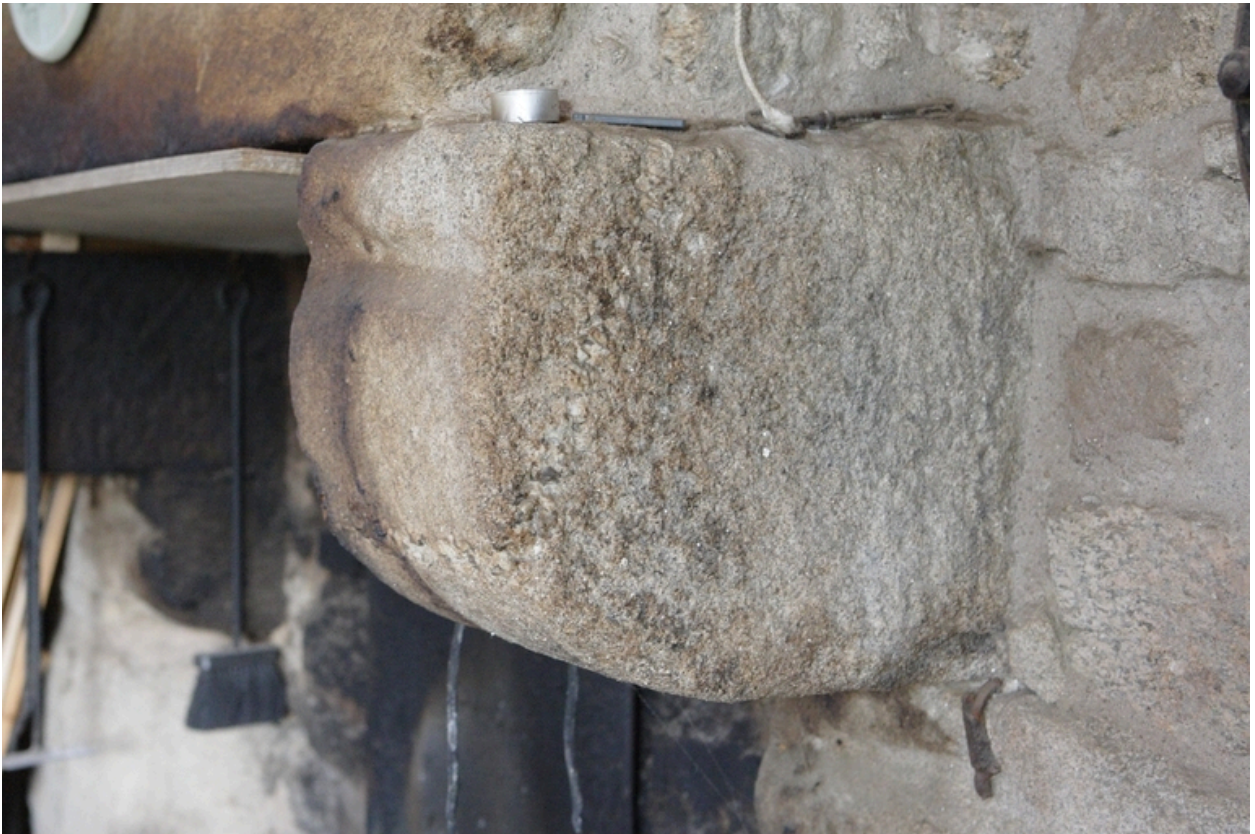
N° 10 rue du Rigouic. Détail du corbeau de droite de la cheminée (extérieur).
