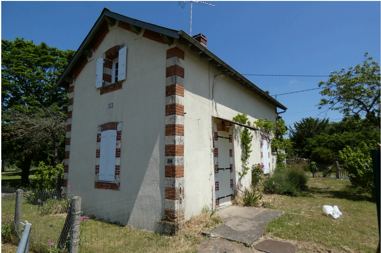
La maison de garde-barrière au sud de la gare, vue depuis l'ouest.
