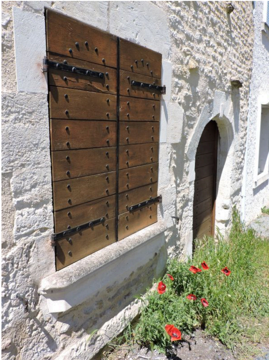
La baie avec appui saillant et mouluré (17e-18e siècle) au rez-de-chaussée.
