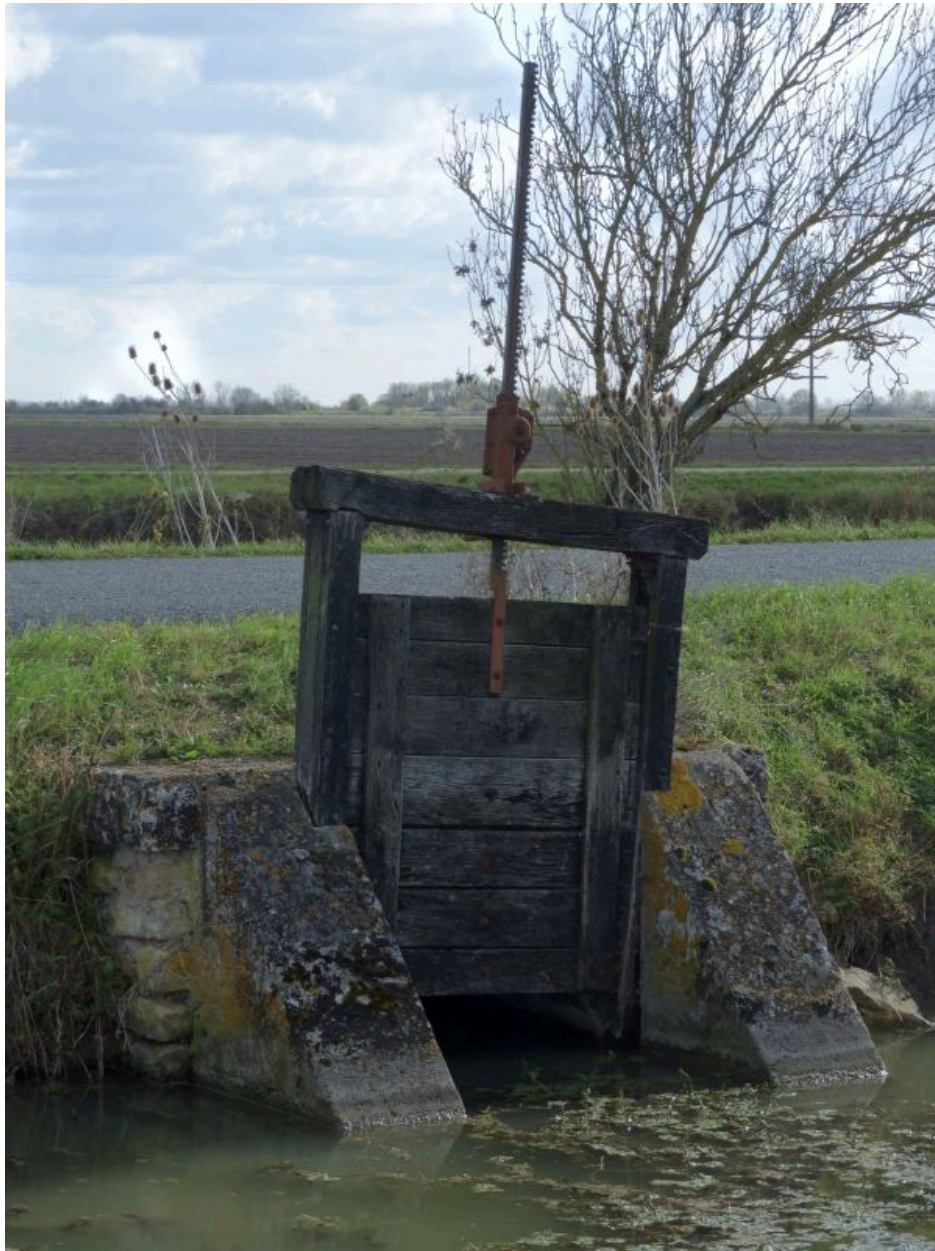
Arceau près de la cabane de Clairvent, à Sainte-Radégonde-des-Noyers, sur la rive droite du canal du Clain, avec crémaillère en métal.
