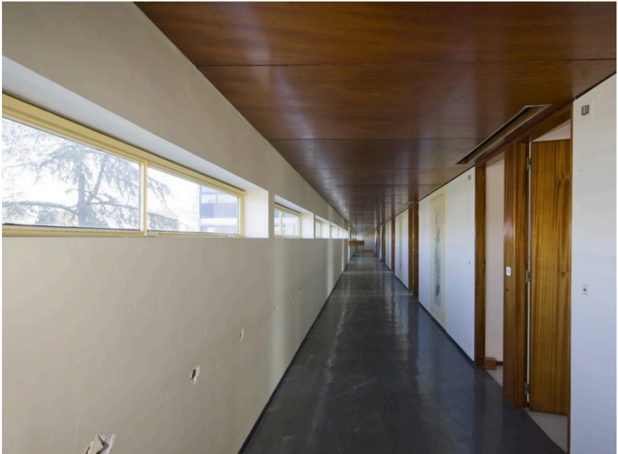
Vue du couloir du premier étage.
