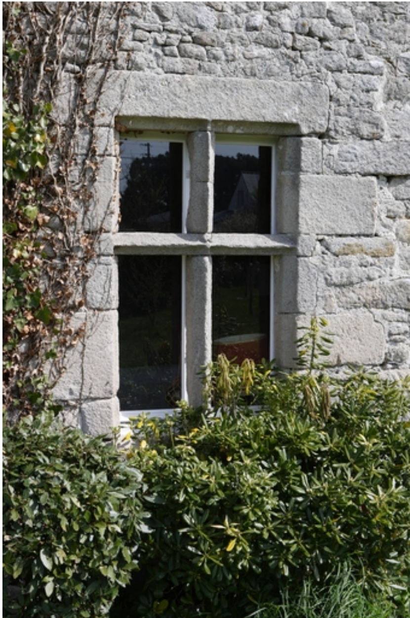
Façade sud. Rez-de-chaussée. Détail de la croisée de la salle basse.
