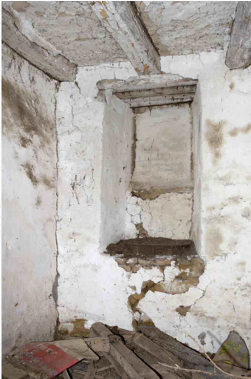
Aile sud. Fenêtre bouchée.
