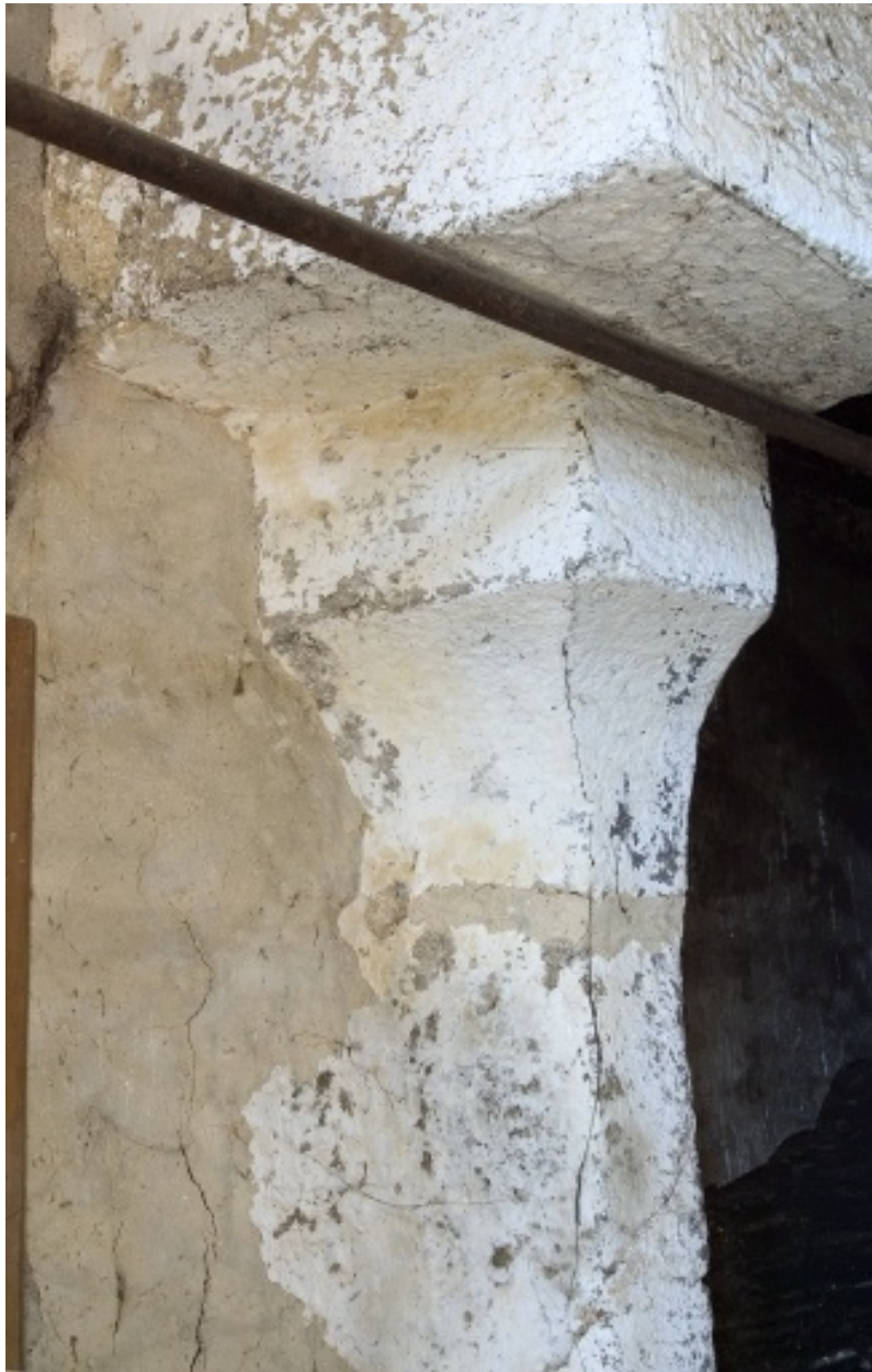
Intérieur du logis, premier étage, chambre sud : corbeau gauche de la cheminée.
