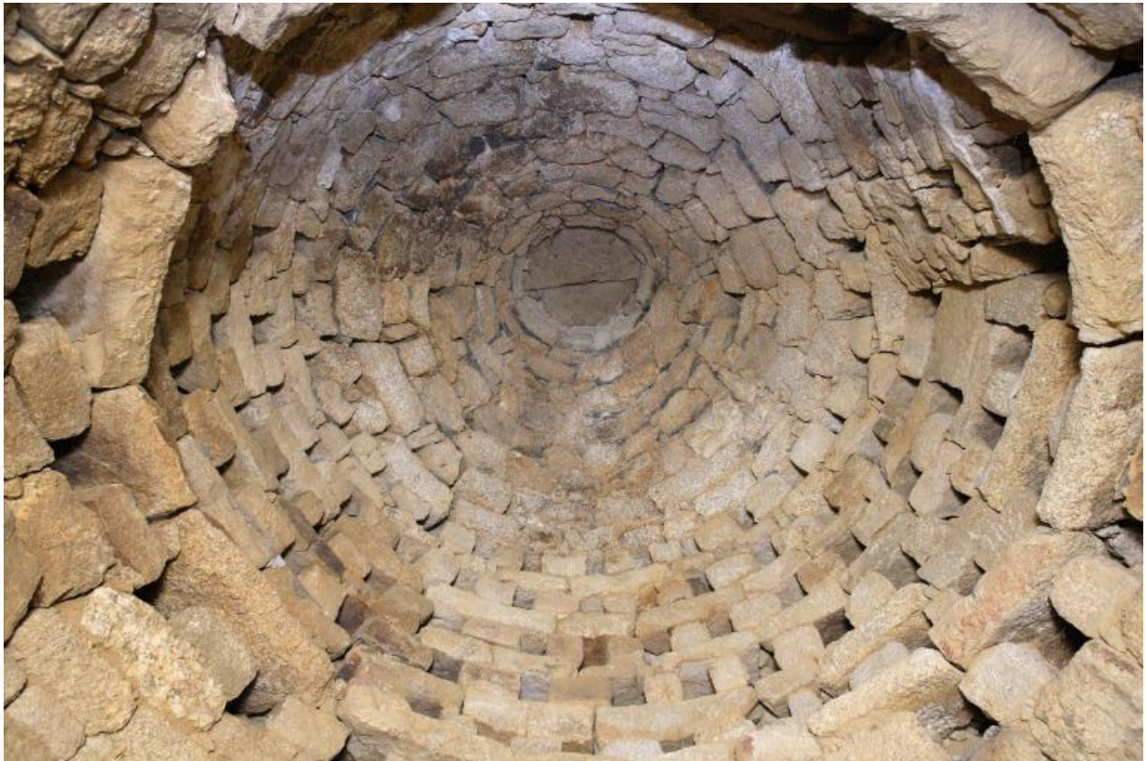
Logis. Tour d'escalier. Pigeonnier.
