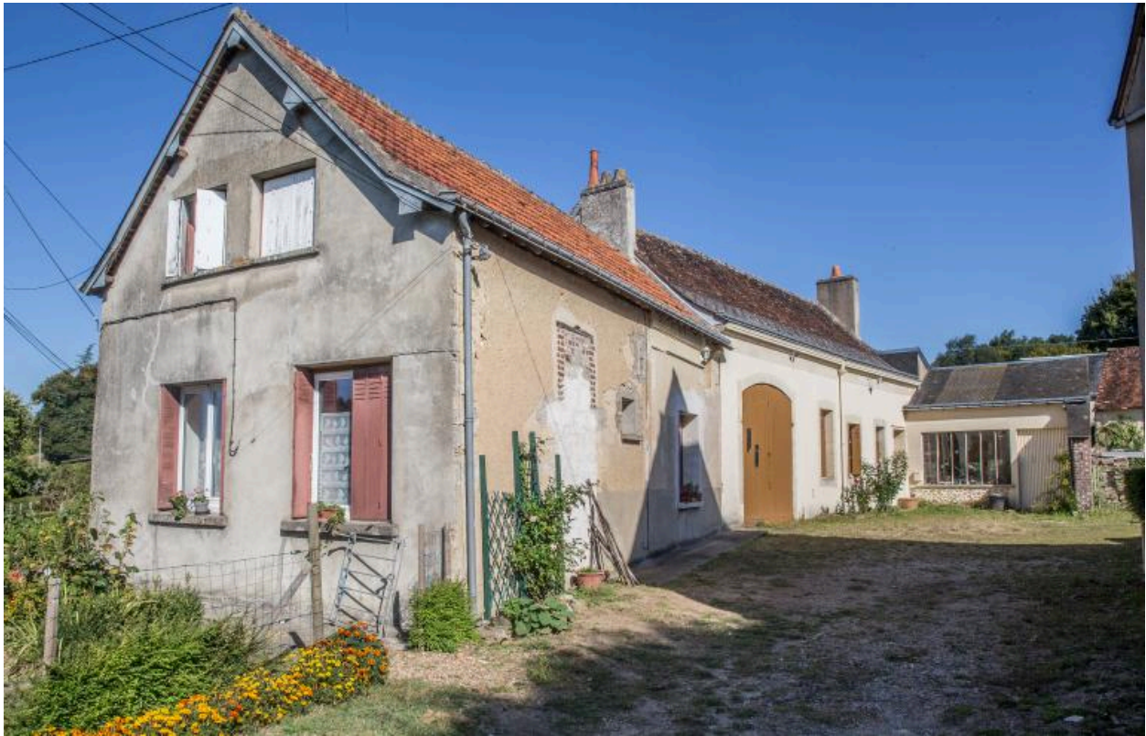
L'écart vu depuis l'ouest (site du prieuré).
