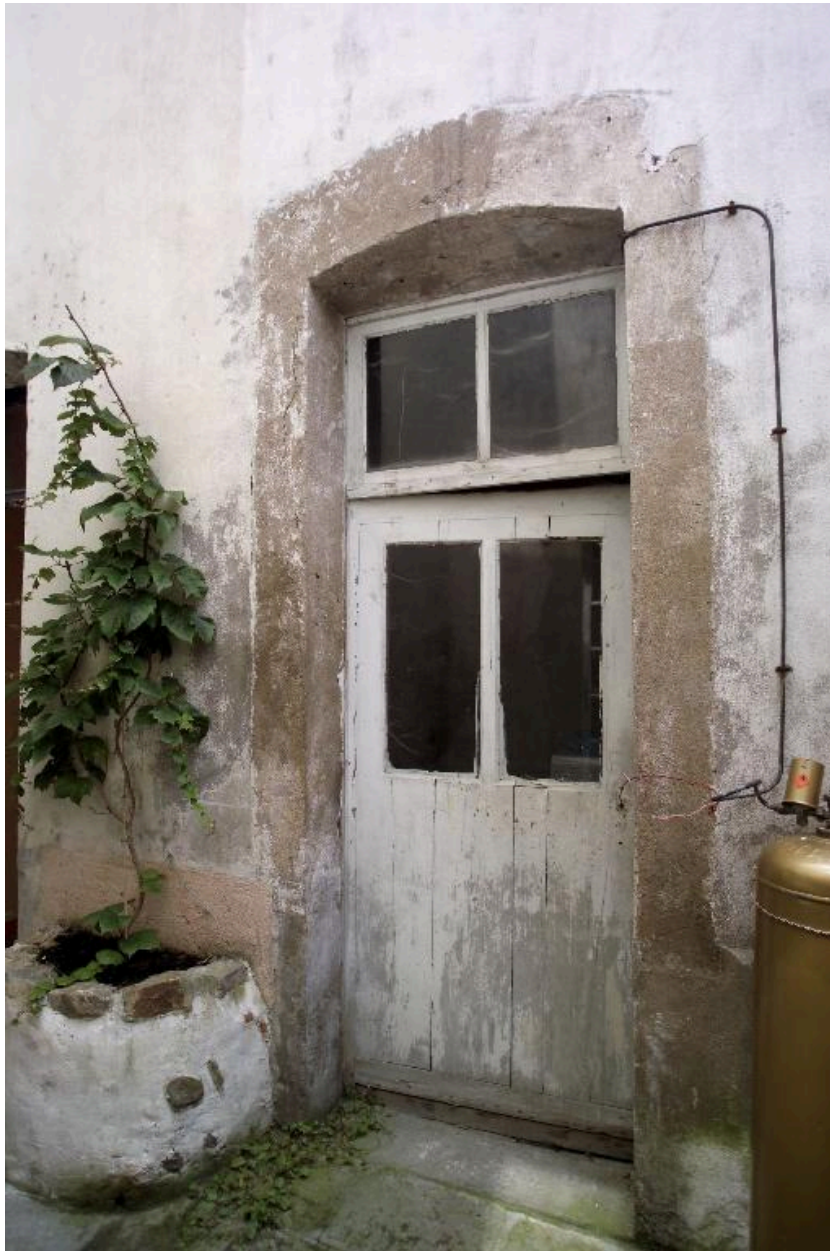
La porte d'accès au corps de logis sur le quai, depuis la cour.
