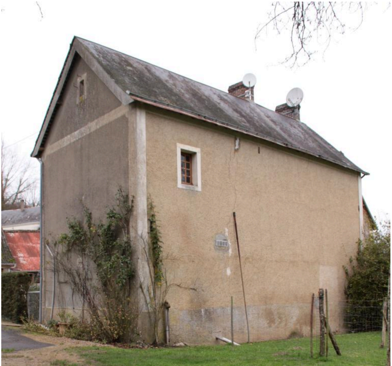
Maison 2, vue de volume : mur pignon et façade postérieure.
