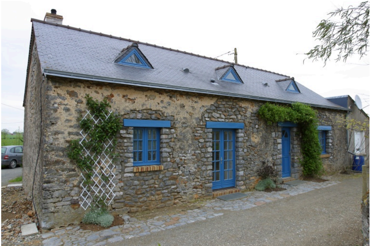
La façade principale du logis, au sud.
