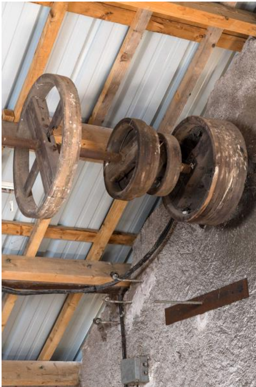
Diverses poulies pour courroies plates situées à l'étage de l'usine.
