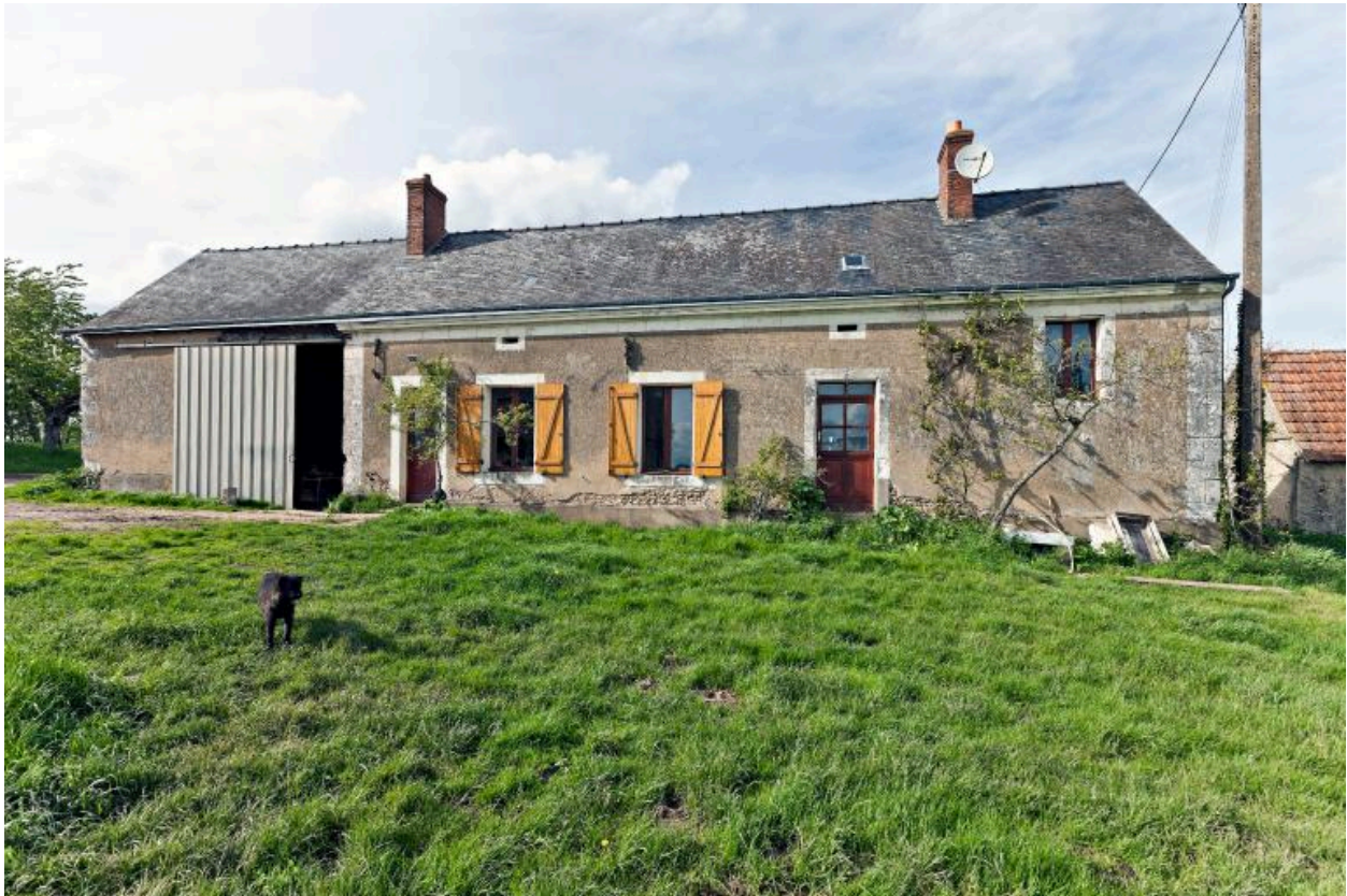
Ferme bloc à terre, plus étables en face, et hangar formant une grande cour ouverte. L'Hêtre Rousseau.
