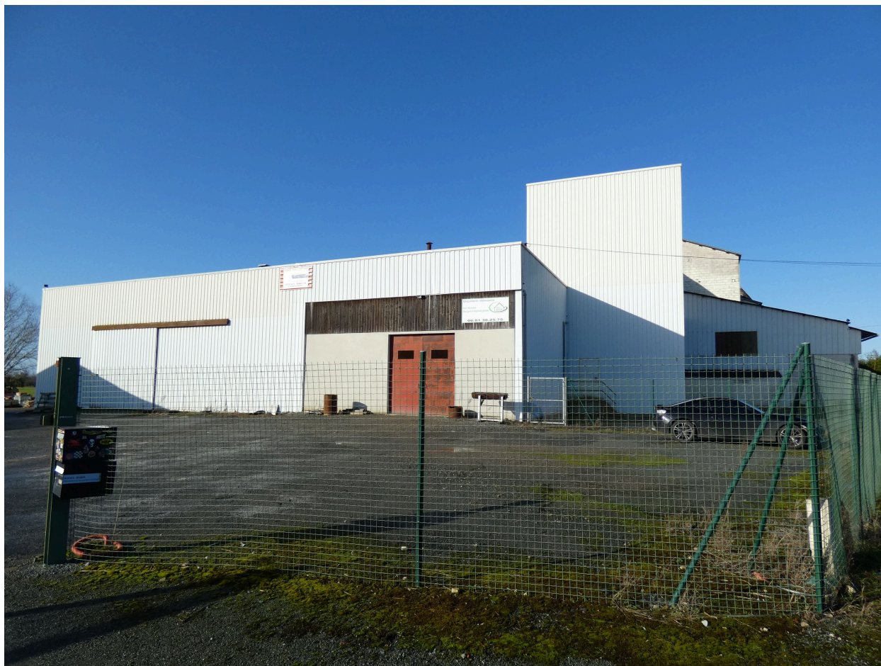
Le bâtiment de stockage et de déchargement, actuels locaux d'entreprises, vu depuis l'est.
