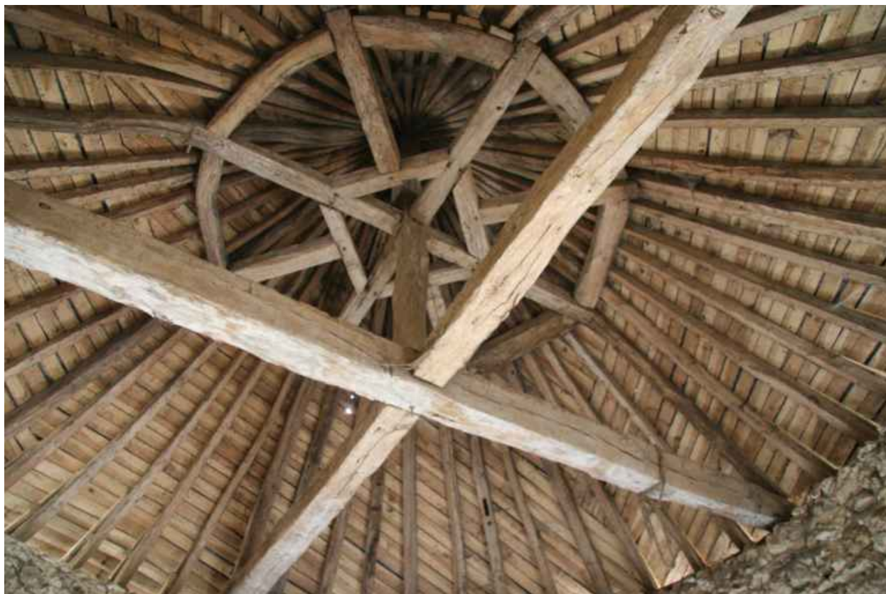
Tourelle d'angle : charpente.
