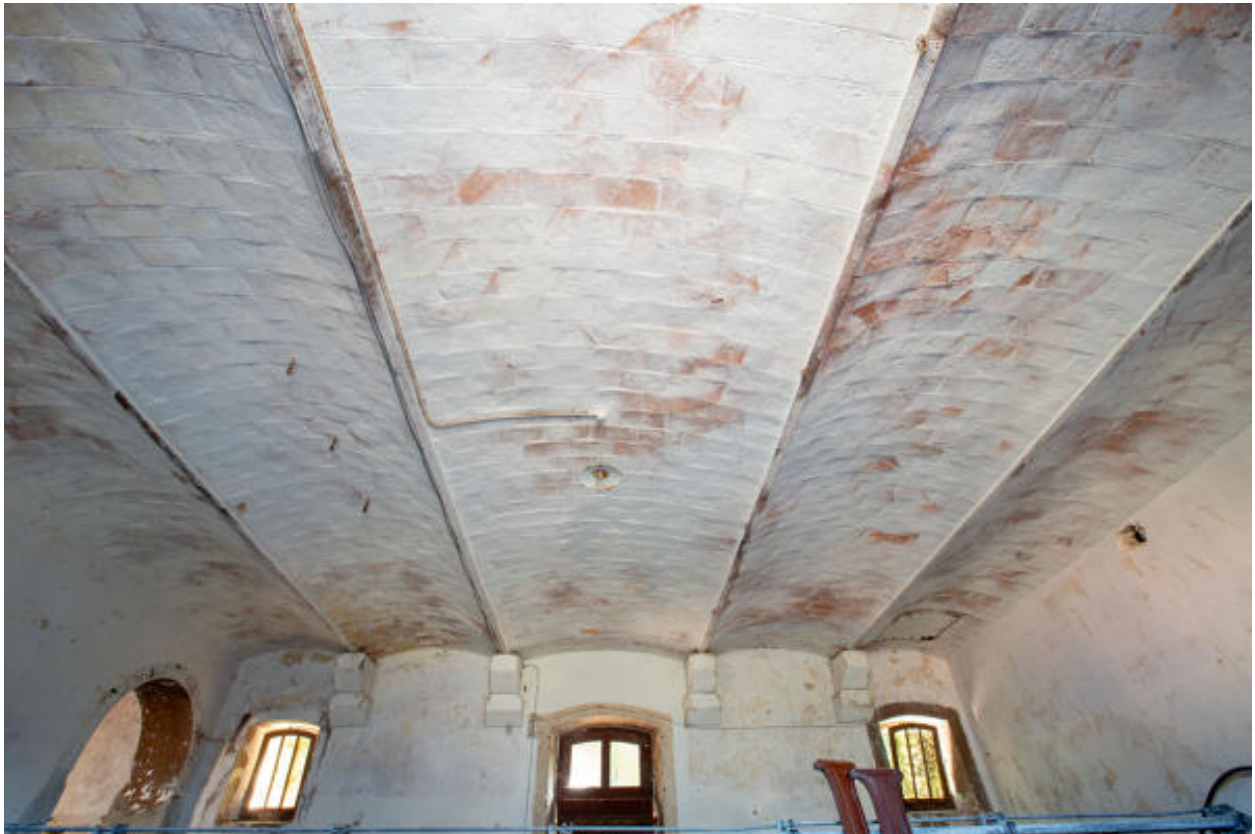
L'écurie, détail d'un plafond.
