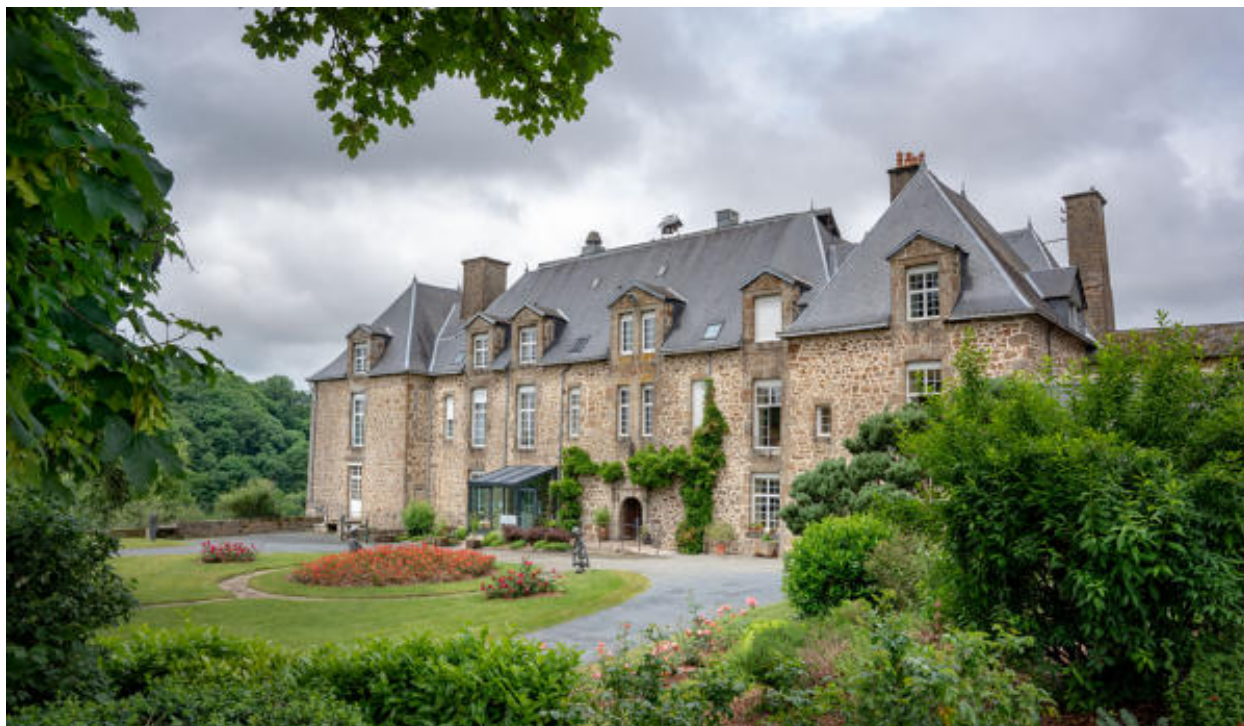
La façade antérieure du château.
