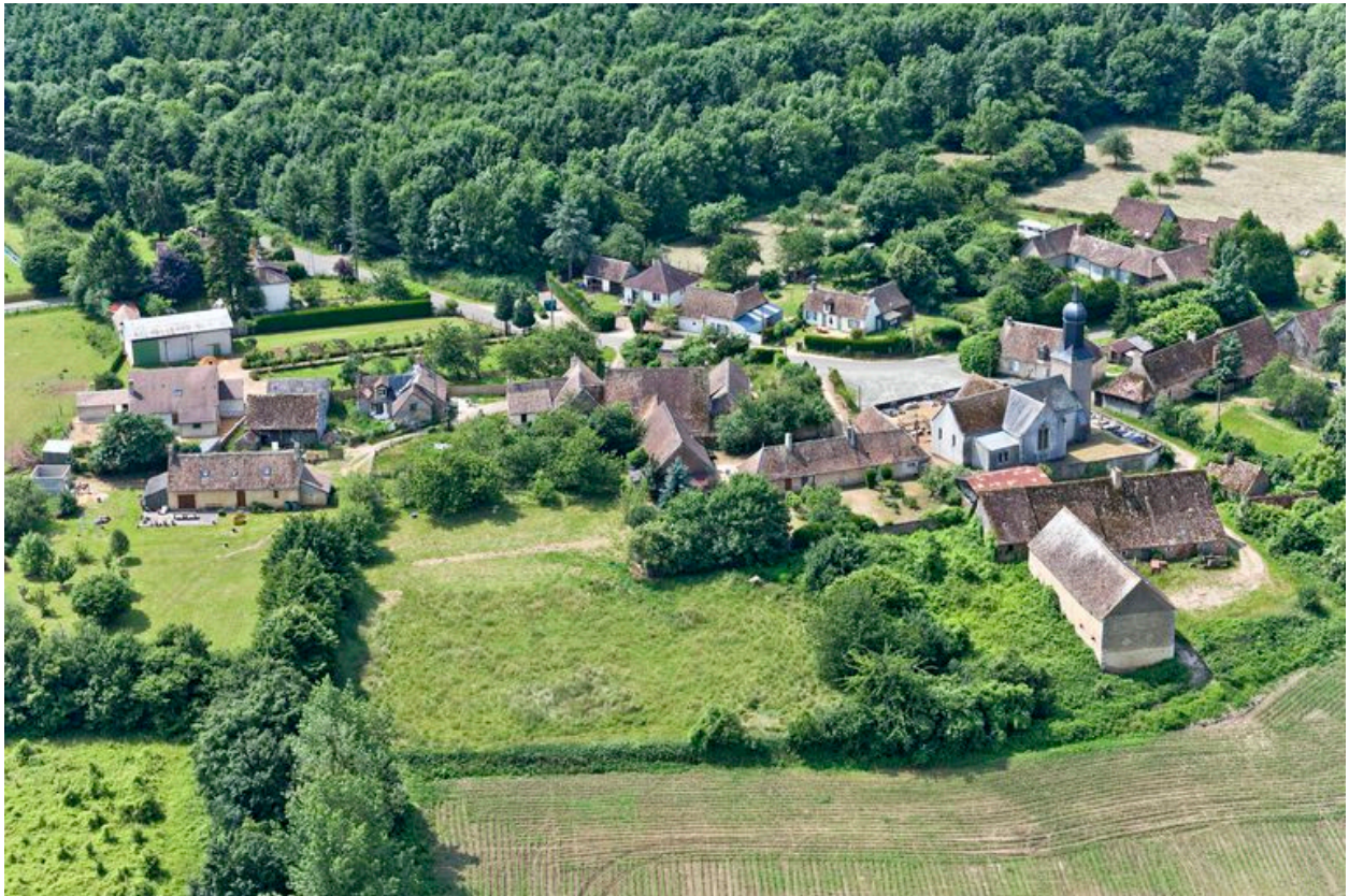
Vue aérienne depuis le nord.
