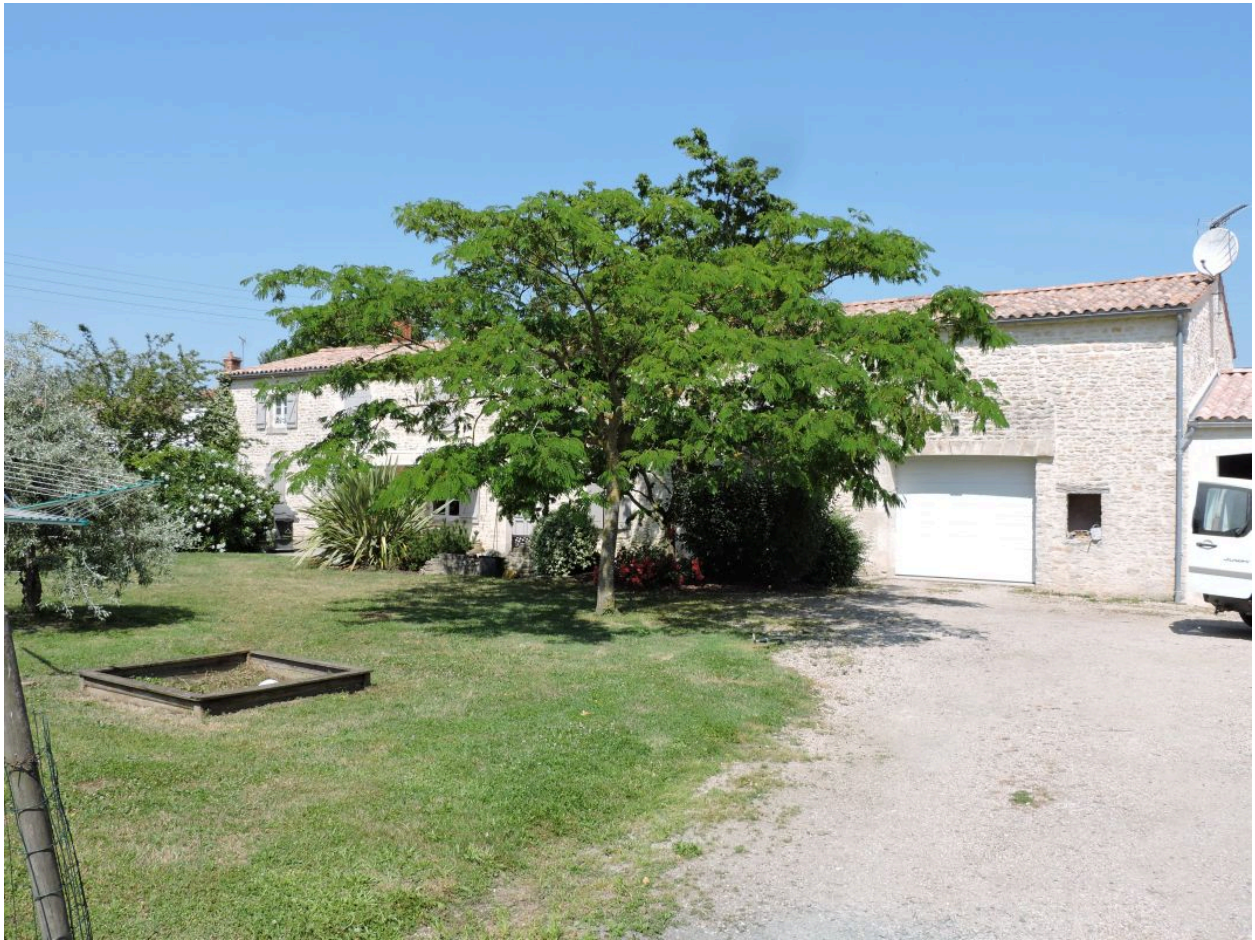
La ferme vue depuis l'est avec, de gauche à droite, le logis et les dépendances.
