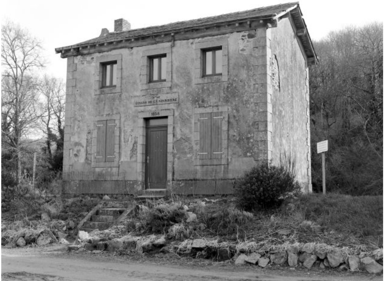
La maison éclusière.
