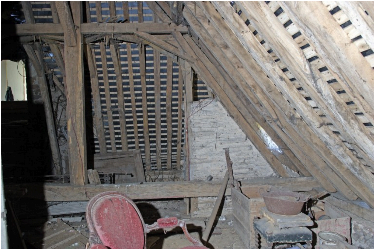
Comble du pavillon : la partie inférieure de la charpente vue depuis le nord.
