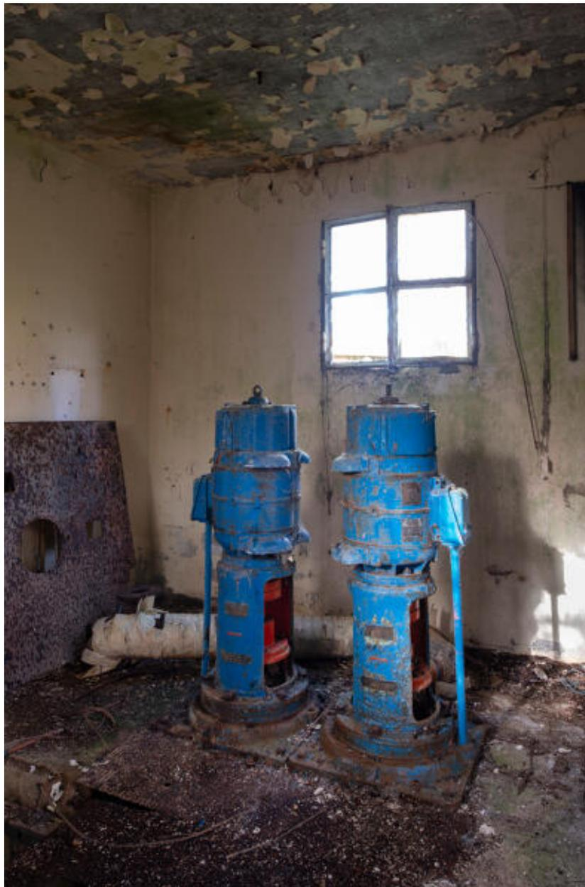
Les deux moto-pompes électriques verticales Bergeron en place dans le bâtiment de 1937.
