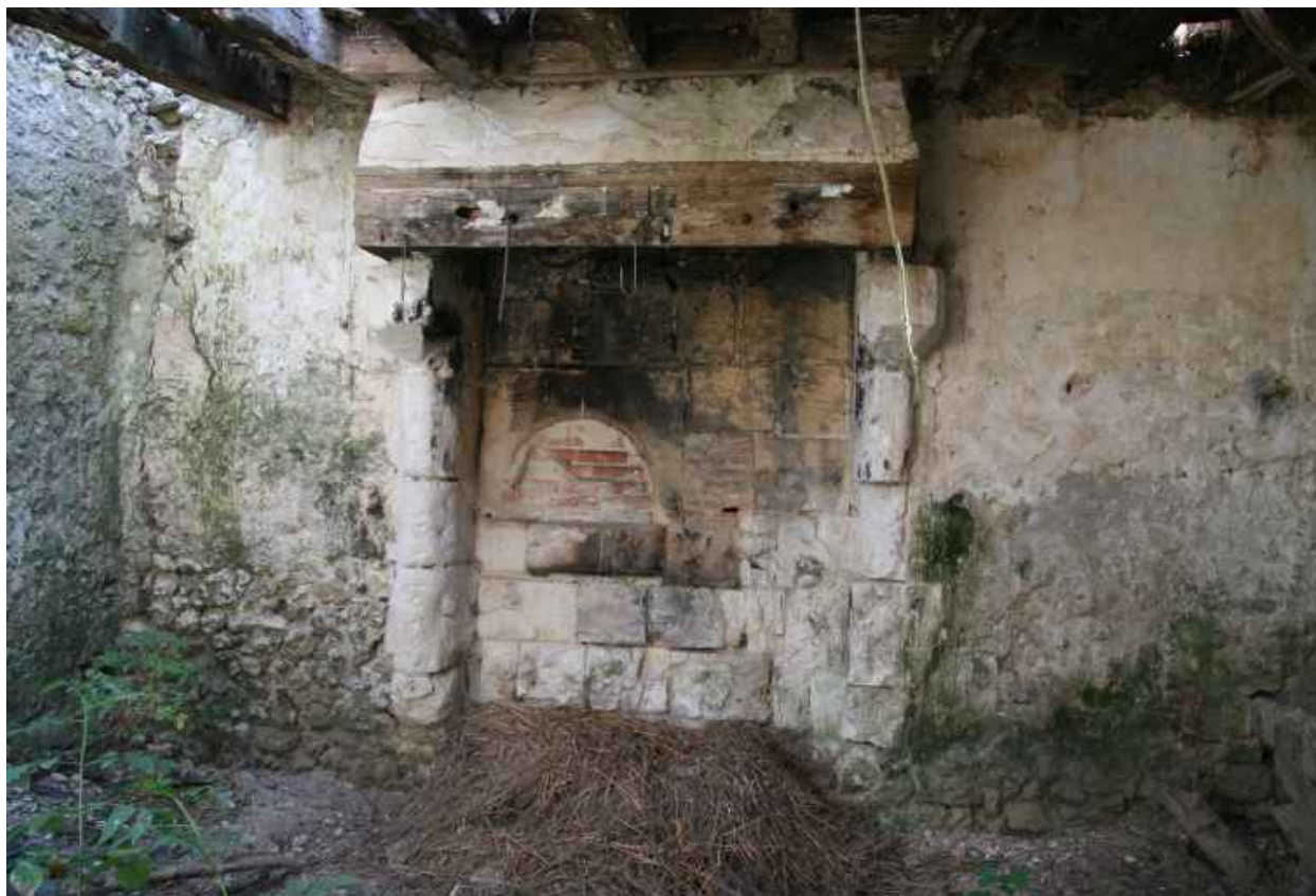
Maison n°2 : la cheminée.
