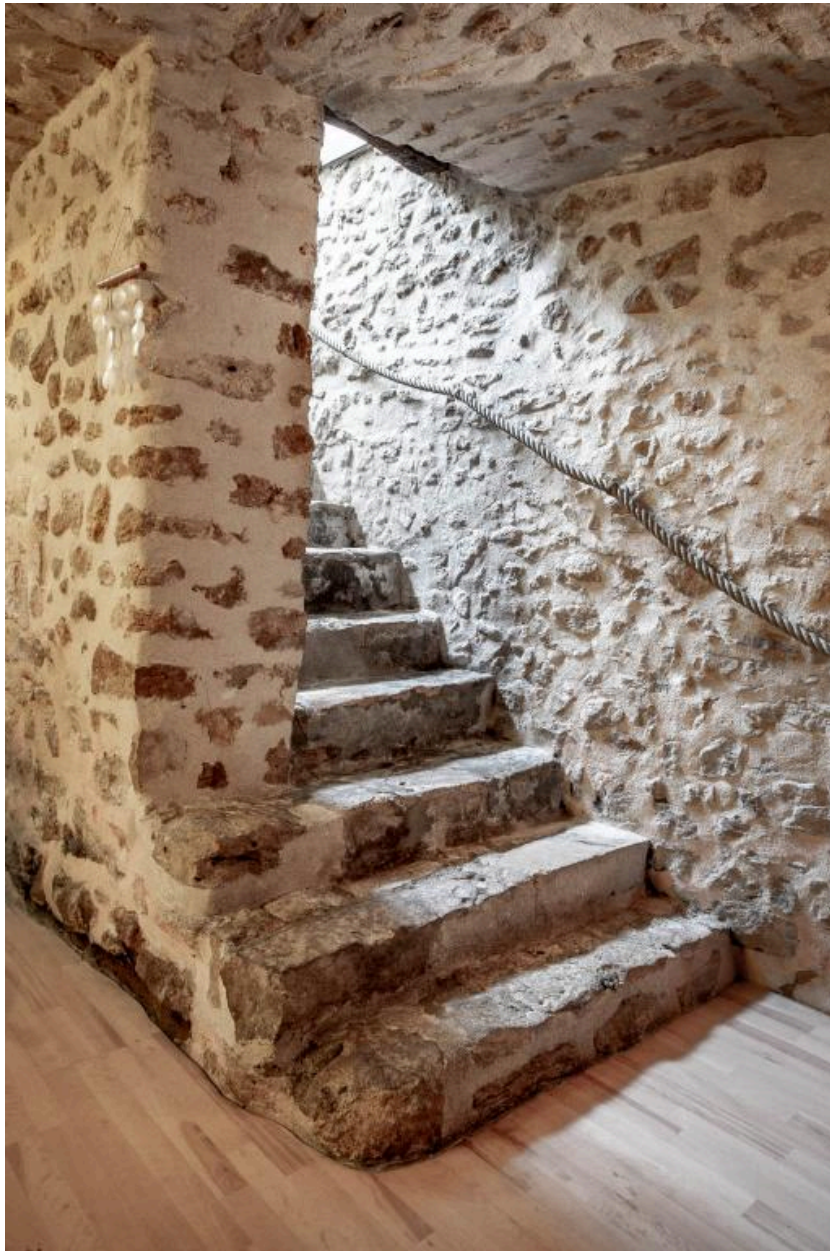
Un escalier d'accès à une cave, Epoque Moderne ?, Grande rue.
