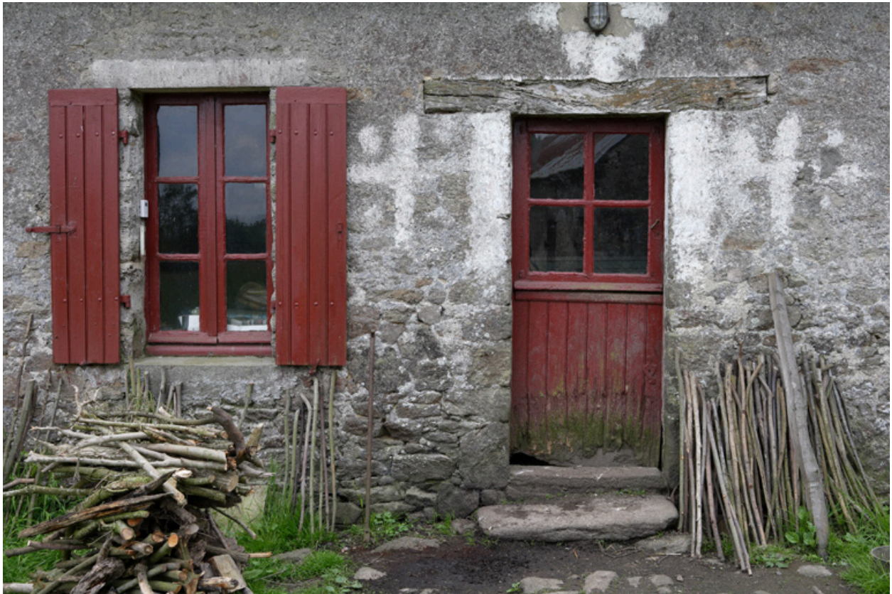
Logis. Façade nord. Porte et fenêtre, détail.
