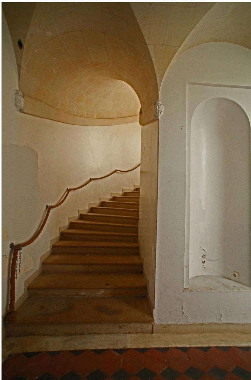
Escalier monumental dans œuvre, 1ère volée.
