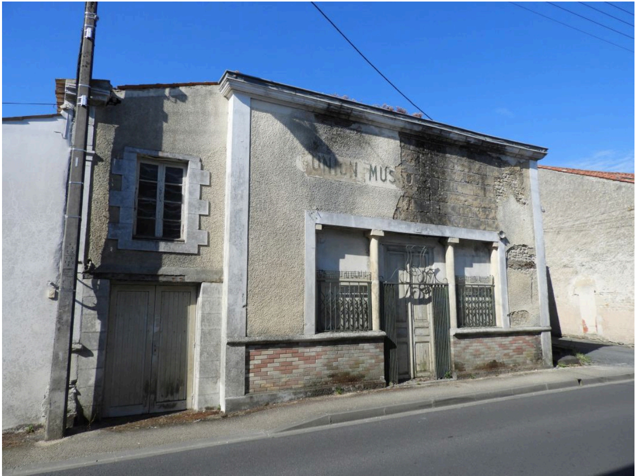
La façade nord de la salle.
