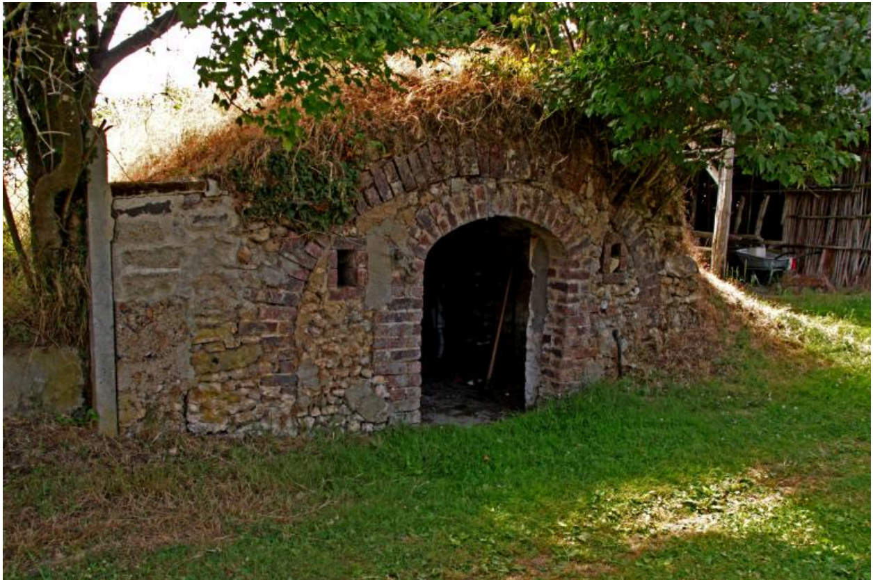
Cellier semi enterré.
