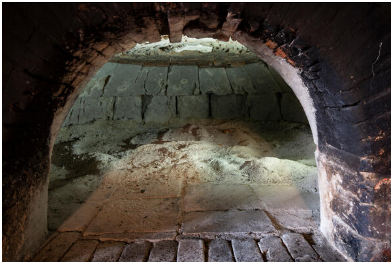
Logis : intérieur du four à pain.
