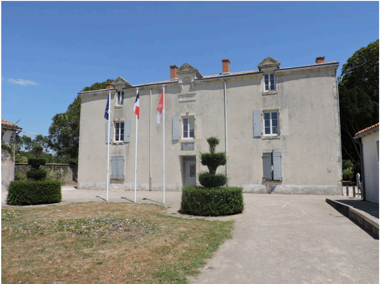
La demeure Prouzeau, actuelle mairie, maison de maître construite vers 1825.
