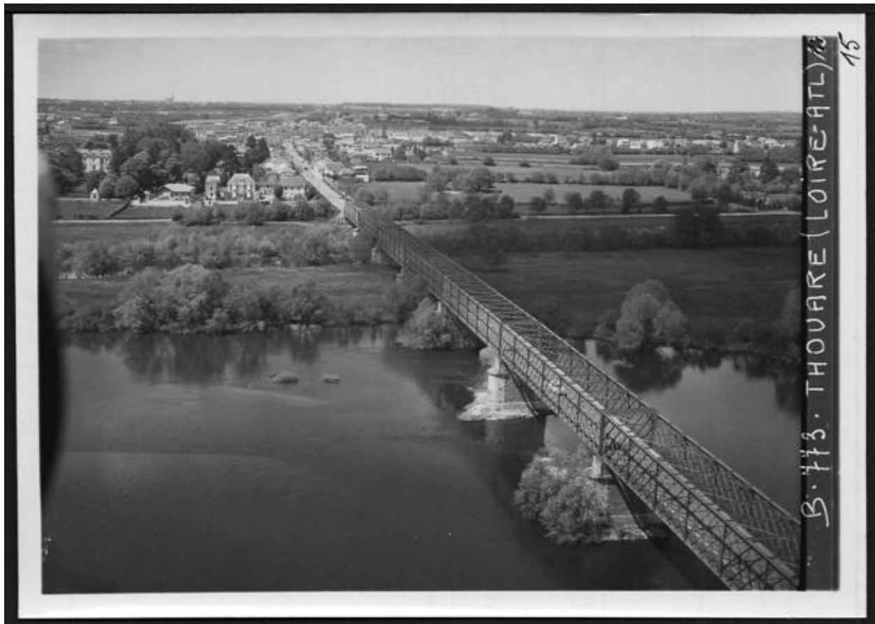
Vue aérienne du pont depuis le sud.
