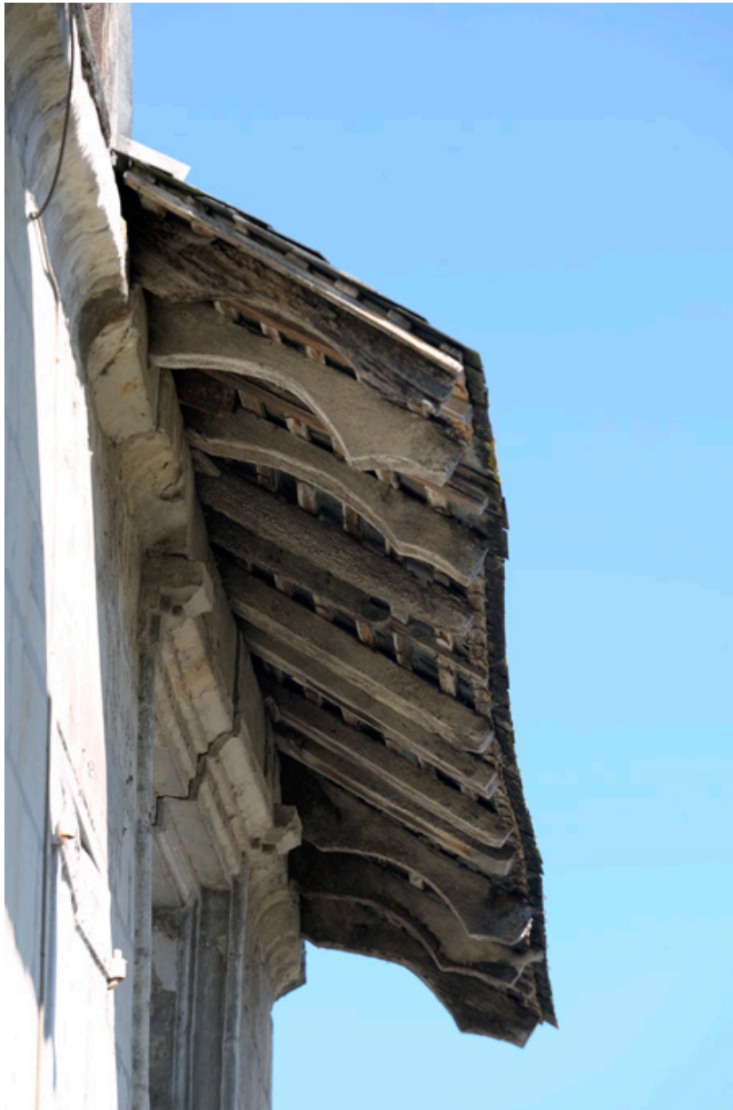
Façade est. Détail du profil des coyaux.
