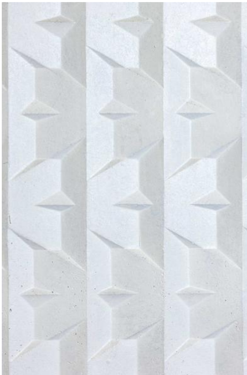
Moulurations panneaux béton intérieurs de l'église.
