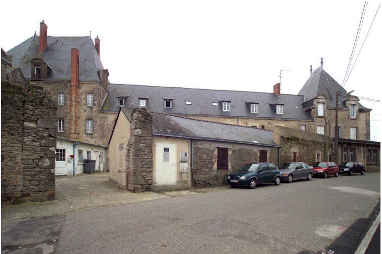
Vue générale de la façade nord.
