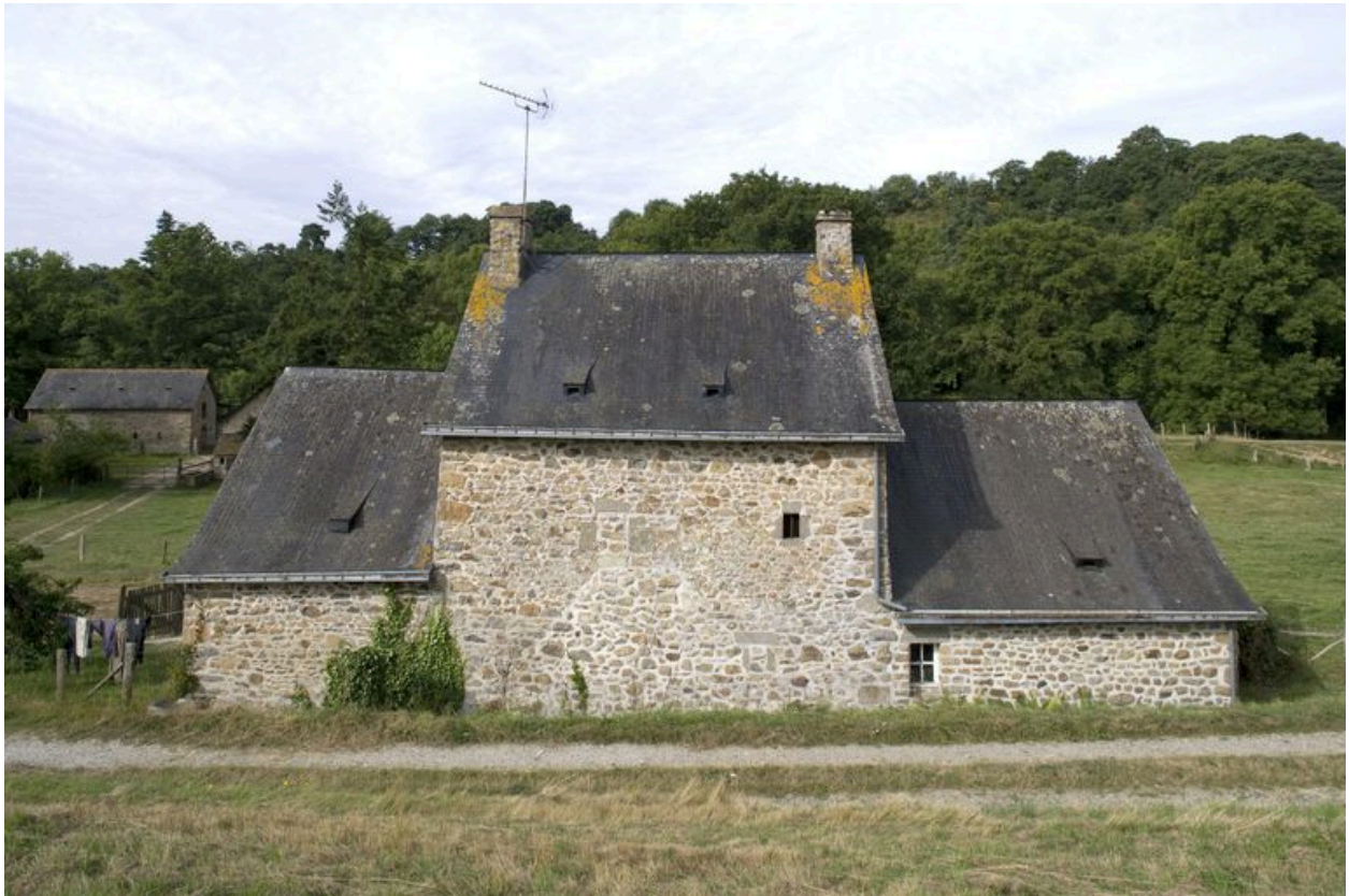
Le logis de métayer (?) : façade postérieure vue depuis le nord-est.
