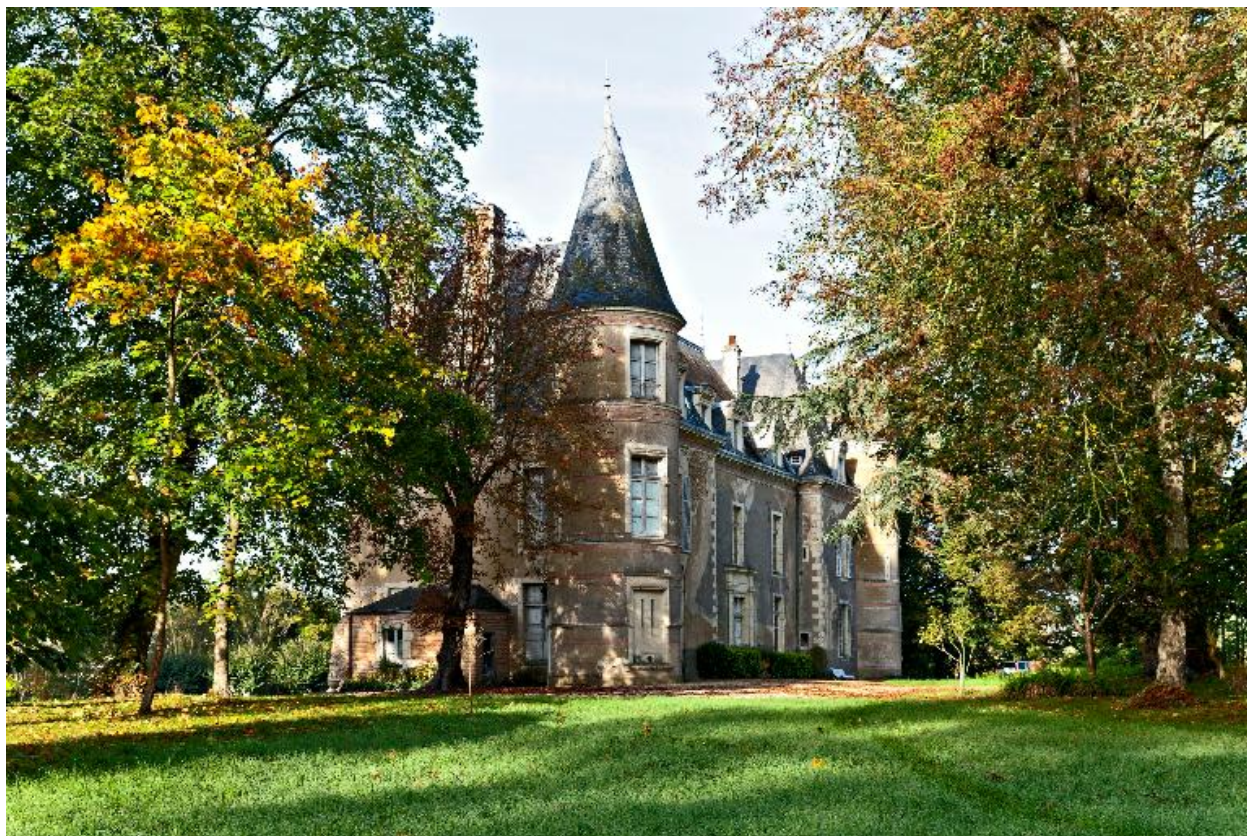
Le château vu depuis l'est : les élévations antérieure et latérale sud.
