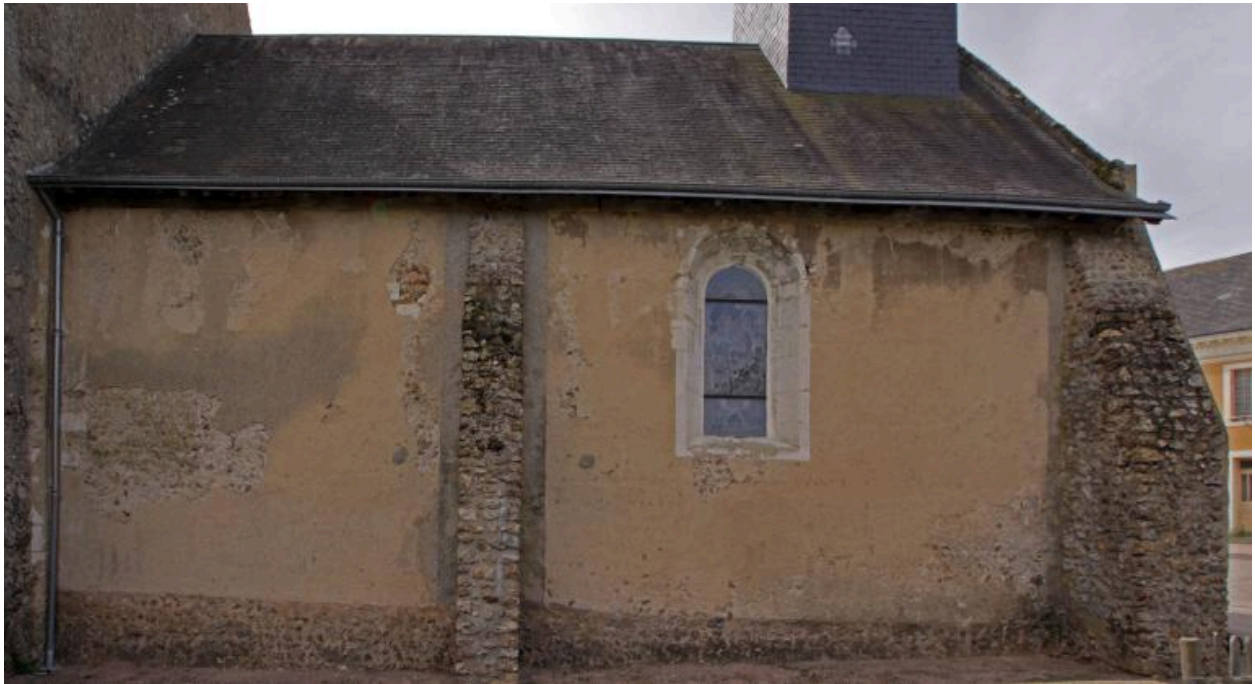
Nef, façade nord.
