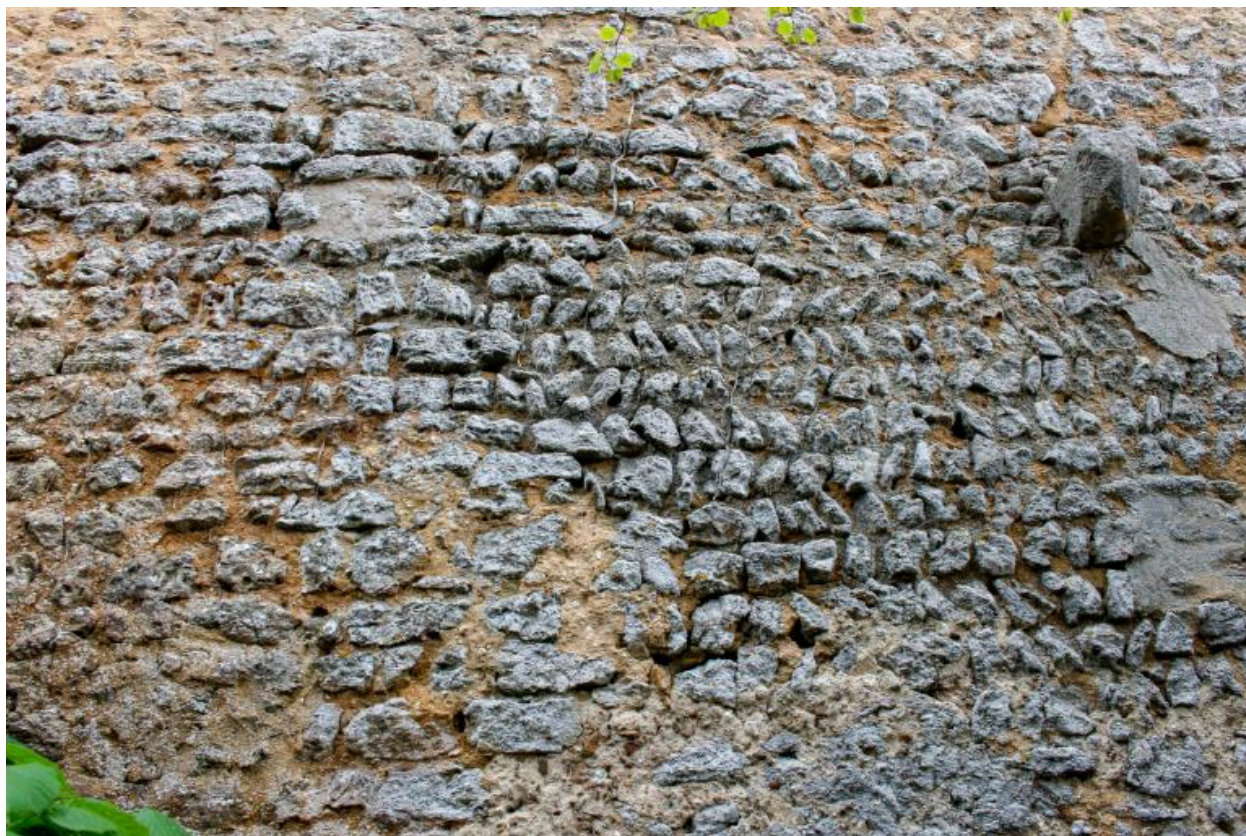
Un détail de la maçonnerie du mur nord de la nef.
