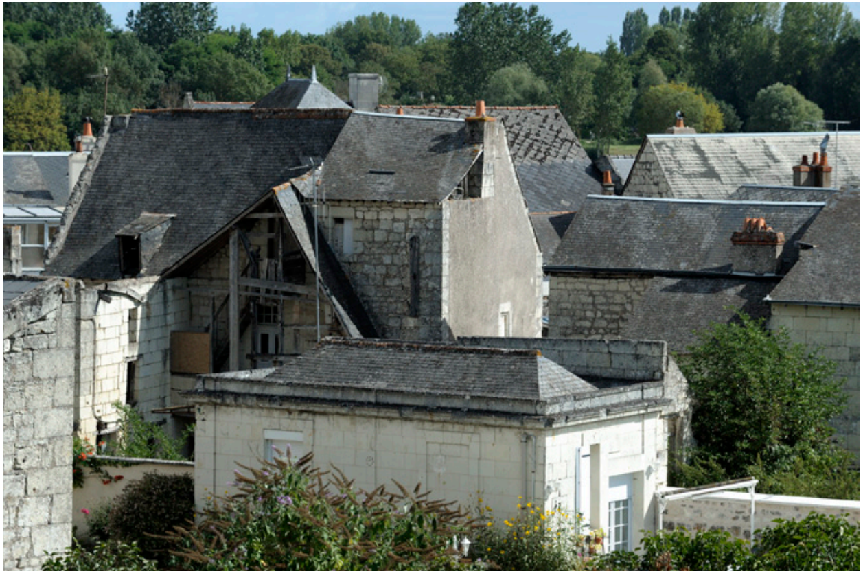
Façade ouest, vue depuis la ruelle des Ouches.
